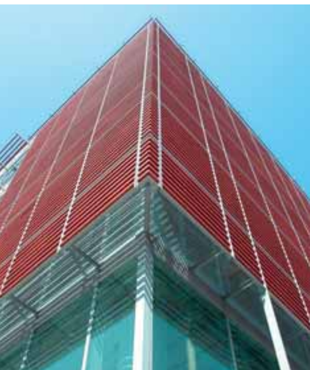
Dettaglio prospettico di facciata che evidenzia l'utilizzo composito dei materiali.
